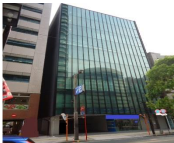
6. 交差点 角から2軒目のビルです
