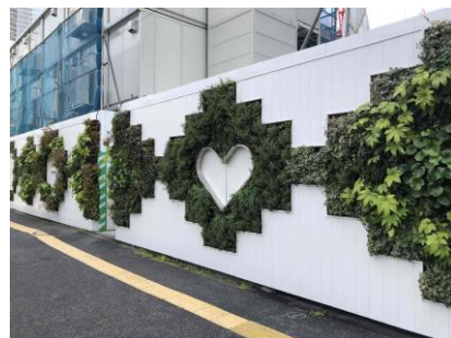
工事中の仮囲い緑化
