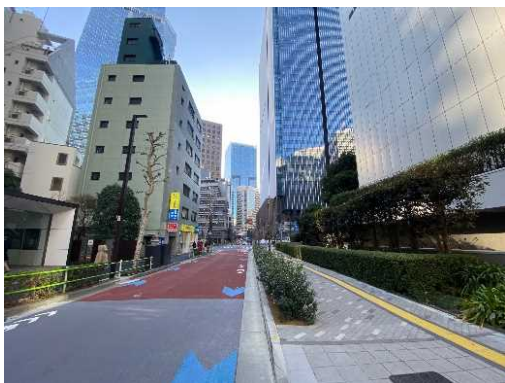
▲虎ノ門駅方面の歩道拡幅【特別区道第1009号線】
