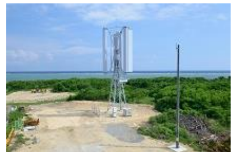
垂直軸型マグナス式風力発電機 (提供:チャレナジー株式会社)
