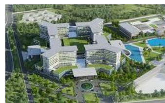
大規模病院建設プロジェクト支援
